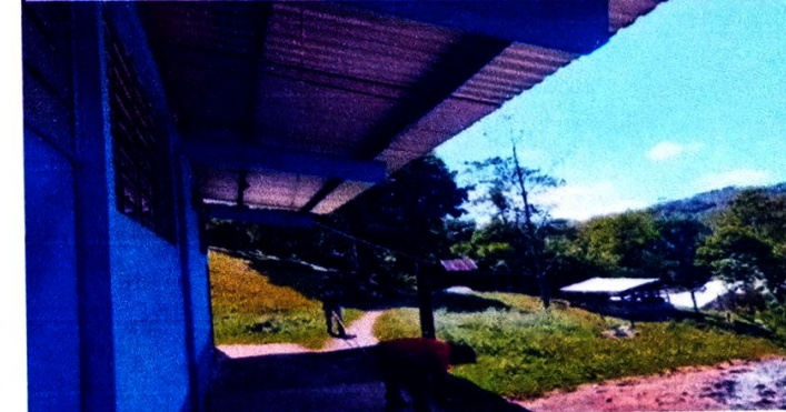
Foto 6: SUSTITUCION DE BAJADAS FLUVIALES
