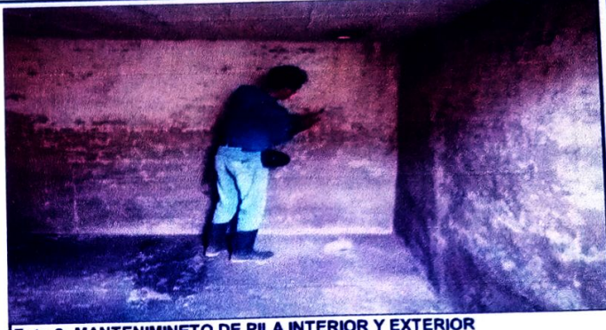
Foto 2: MANTENIMIENTO DE PILA INTERIOR Y EXTERIOR
