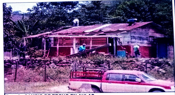
Foto 4: CAMBIO DE TECHO EN AULAS
